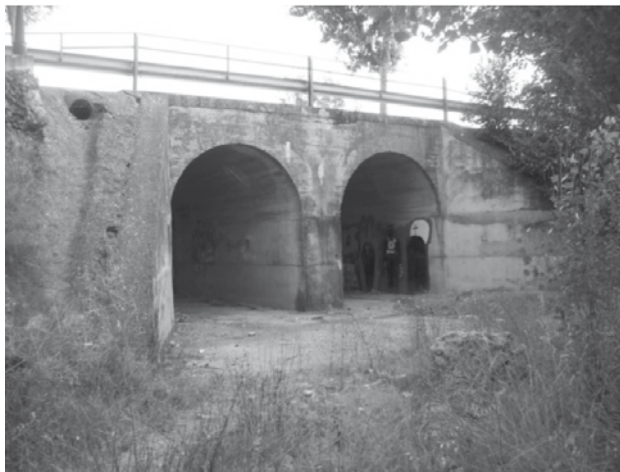
Puentes en la carretera para el paso del reguero de la Fuente de la Virgen de la Cabeza (01-08-2010).
